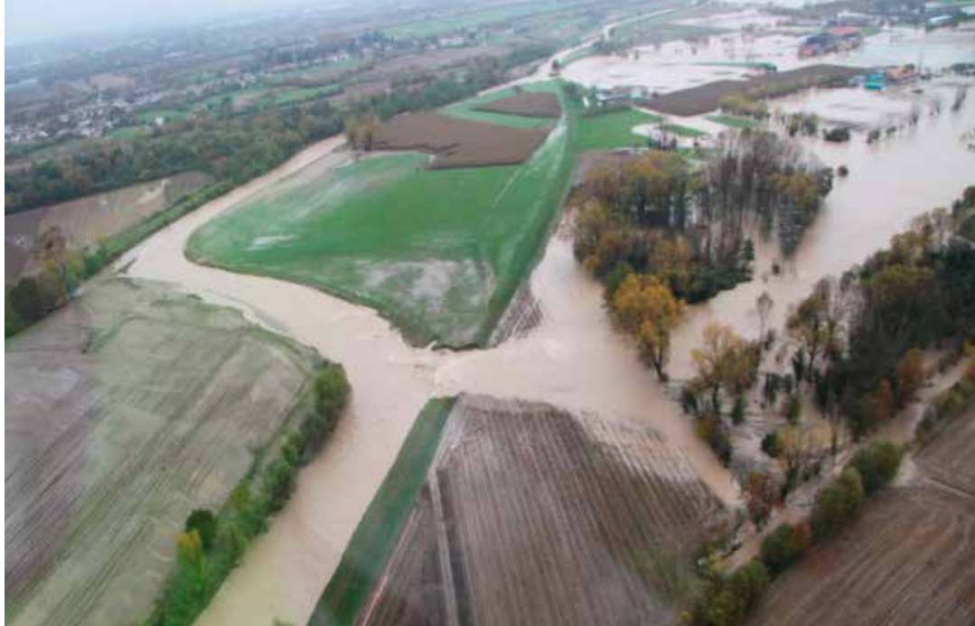
Εικόνα 6: Πλημμύρα του ποταμού Bacchiglione της Βισσέντζα στην Ιταλία
