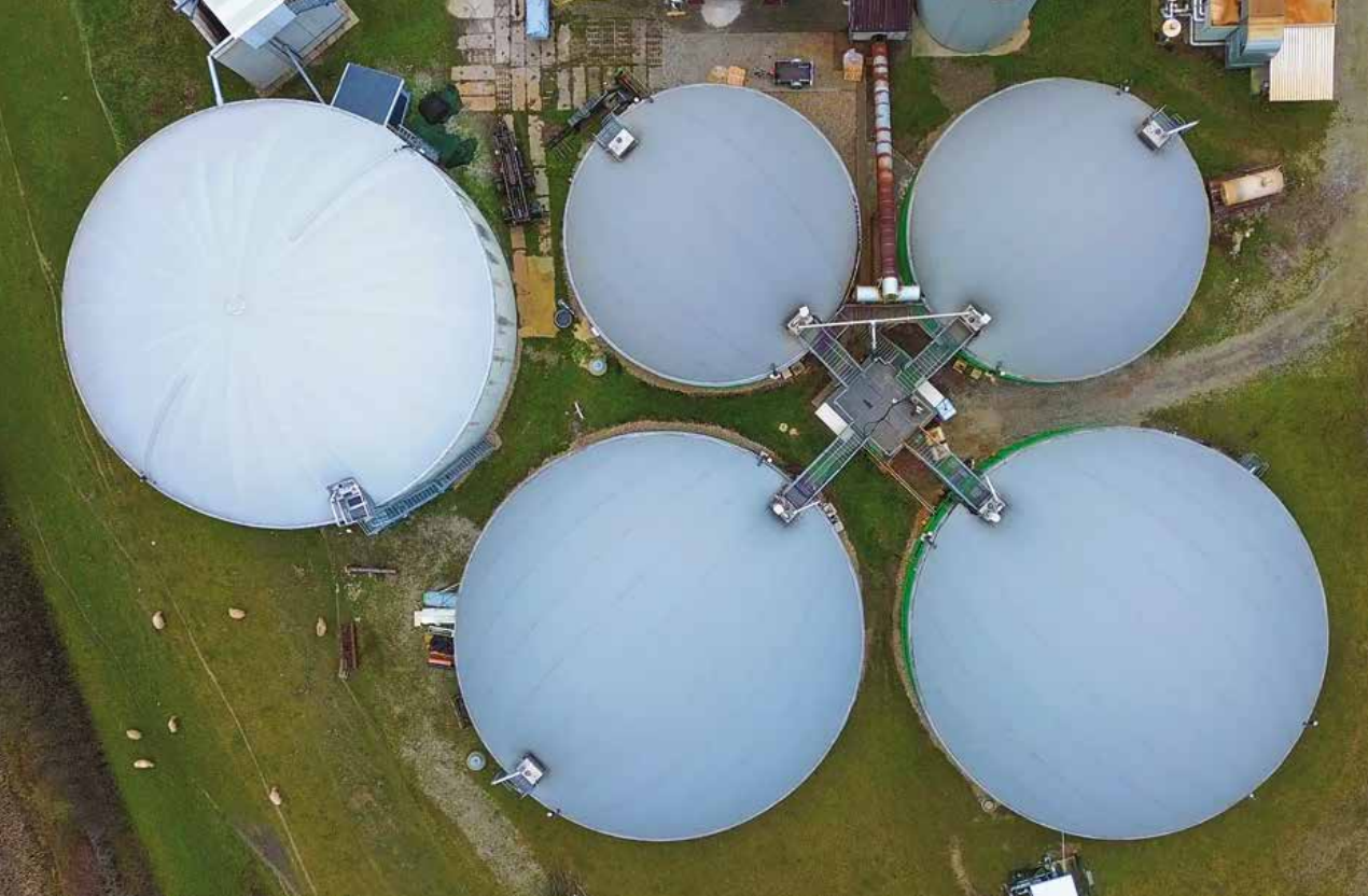
Εναέρια όψη μονάδων παραγωγής βιοαερίου μεγάλης κλίμακας στην Γερμανία
